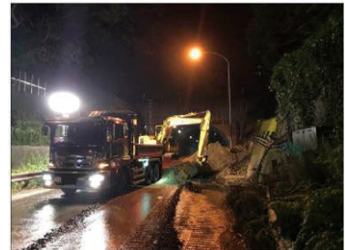
昼夜を問わない復旧作業
