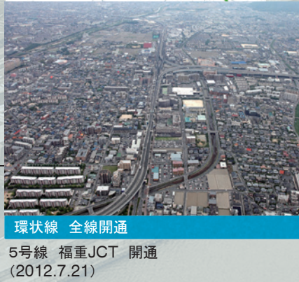
環状線 全線開通 5号線 福重JCT 開通 (2012.7.21)
