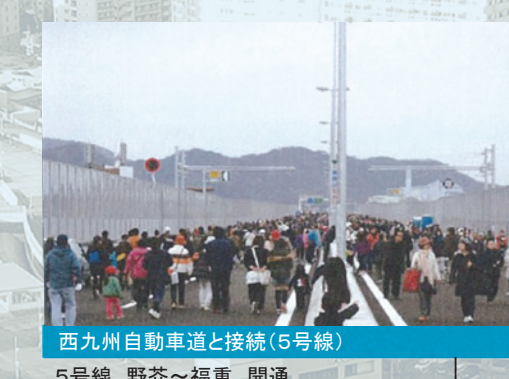
西九州自動車道と接続(5号線) 5号線 野芥～福重 開通 (2011.2.26)
