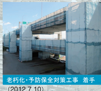
老朽化・予防保全対策工事 着手 (2012.7.10)
