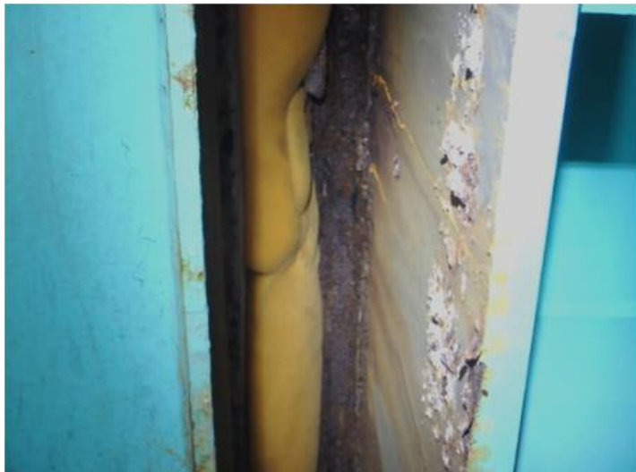
〈狭隘部の腐食状況〉
