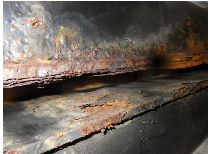
〈狭隘部の腐食状況〉
