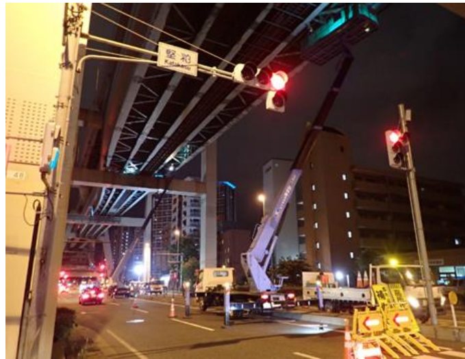
〈狭隘部の点検状況〉
