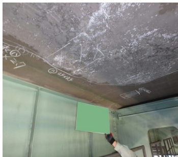
＜コンクリート床版＞ 疲労によるひび割れ・漏水
