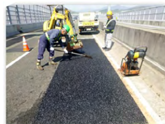
点検・診断結果を基に、計画的な 予防保全補修を実施
