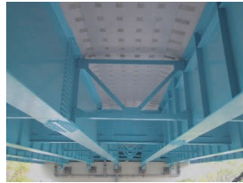
床版（補修・補強後）
