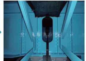
塗装（補修・補強後）
