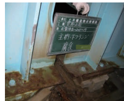
塗装（補修・補強前）
