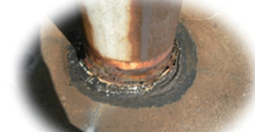
【補修前：支柱基部の状態】
