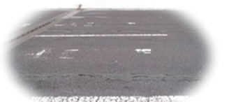
【補修前：路面の状態】
