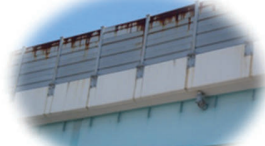
【補修前：金属パネルの状態】
