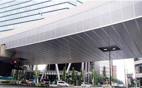
写真11-2-3 点検用恒久足場 ※首都高速道路(株)HP引用
