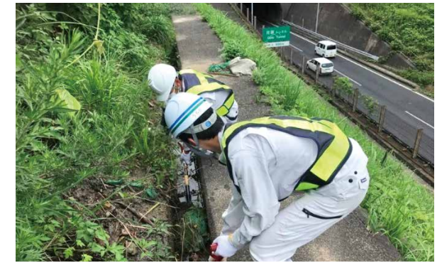
写真11-2-5 職員による側溝の土砂撤去
