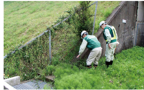
写真11-2-4 職員による法面点検
