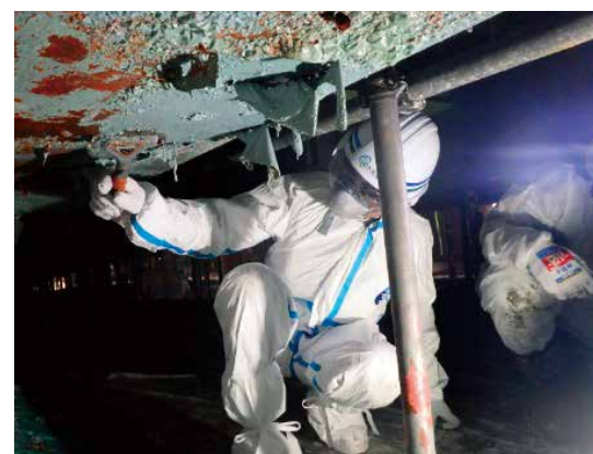
写真-2 塗装除去状況
