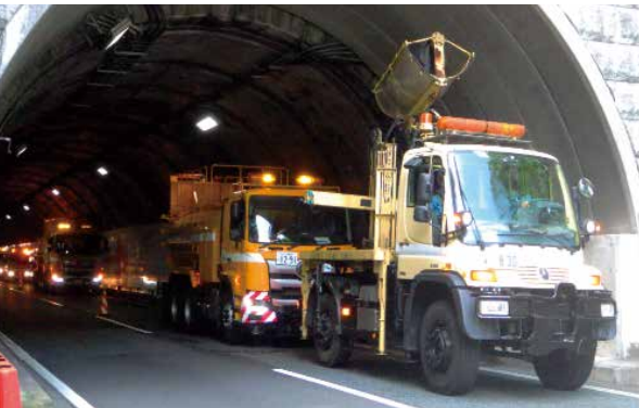
写真5-2-1 トンネル清掃の状況
