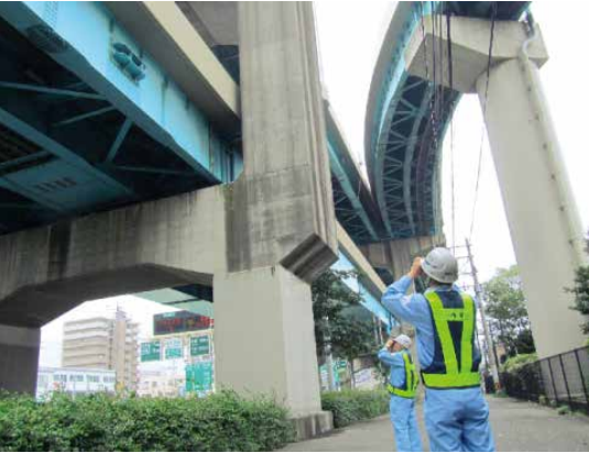
写真-1 橋守活動の状況(遠望目視)
