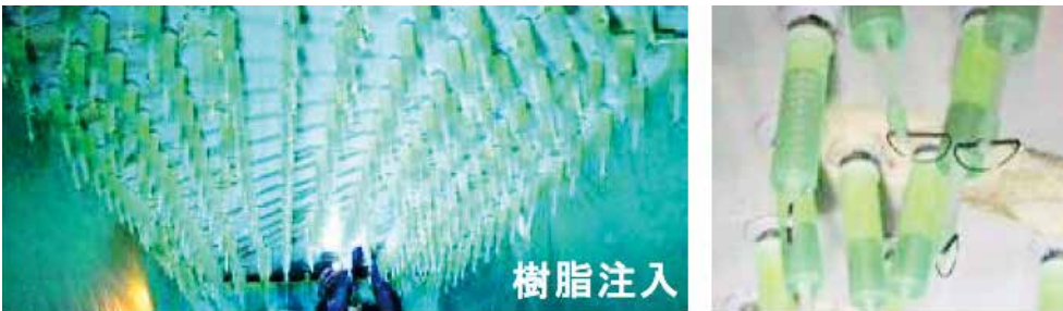
写真5-2-9 RC床版への樹脂注入(IPH工法)工事
