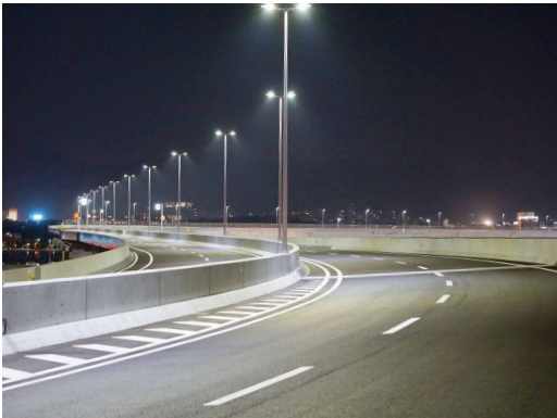
写真5-5-2 道路照明設備
