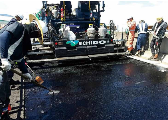
写真5-2-11 舗装改良工事 (改質グースアスファルト)
