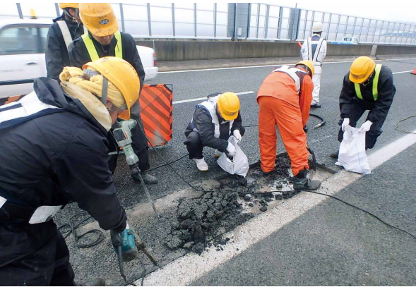
写真5-2-4 緊急補修工事の状況
