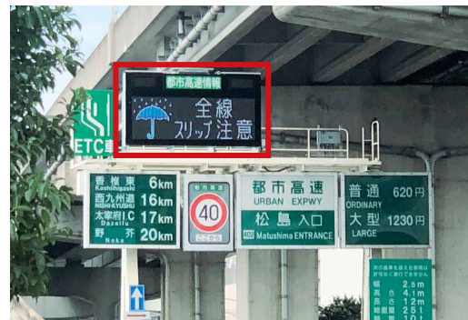
写真5-5-4 道路情報板設備
