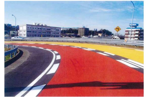
写真7-1-1 対策後(滑り止め工法の誘導案内)
