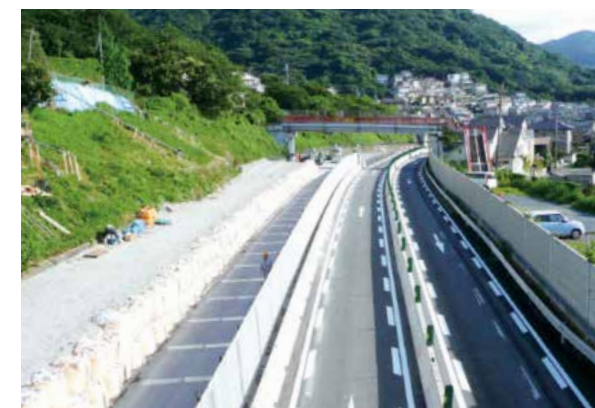
写真8-2-1 (第1段階)暫定供用時の状況
