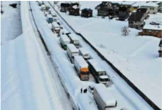
写真8-1-5 関越自動車道の滞留状況
