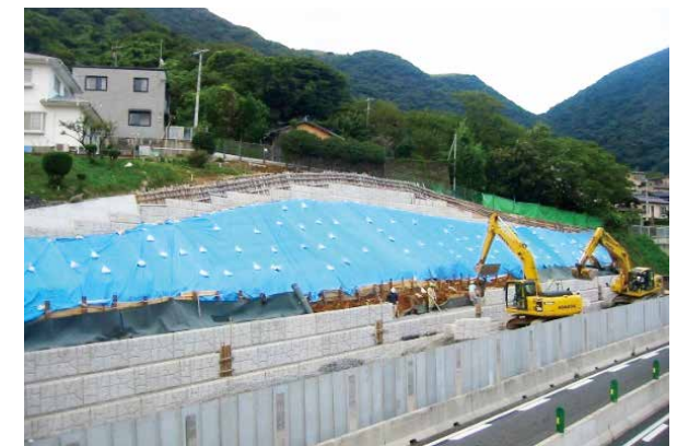
写真8-2-2 (第2段階)復旧工事の状況
