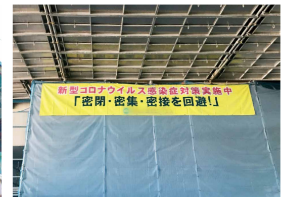
写真8-3-5 工事等での対策
