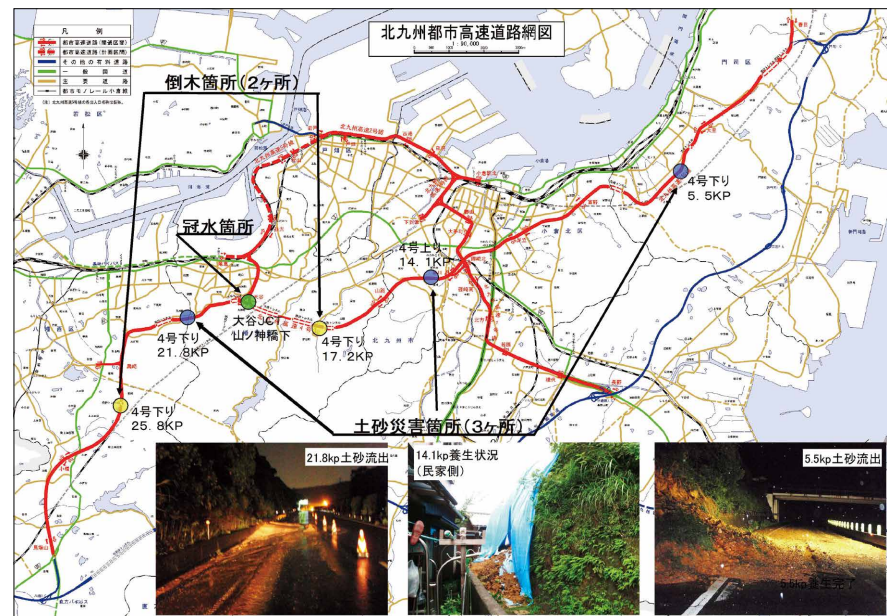
図8-2-3 平成21年7月中国・九州北部豪雨による被災状況
