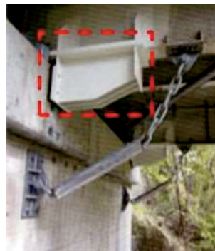
支承周辺と補強部材を整備
