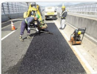
点検・診断結果を基に、計画的な 予防保全補修を実施
