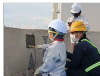
道路補修体験
