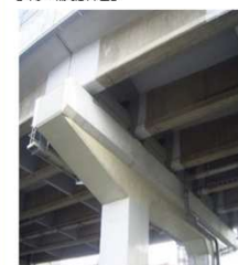
橋脚の桁かかり部分を拡幅
