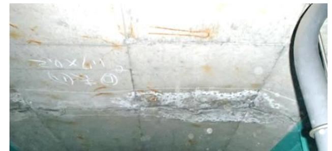
(コンクリート床版下面のひび割れ)
