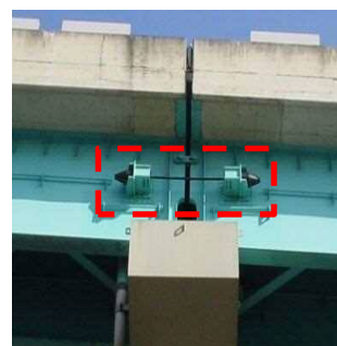
【連結ケーブル設置】
