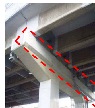
橋脚の桁かかり部分を拡幅
