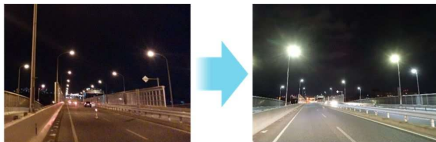
高圧ナトリウム照明 (福岡高速1号線名島付近)
