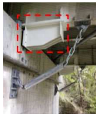
【支承部の補強】
