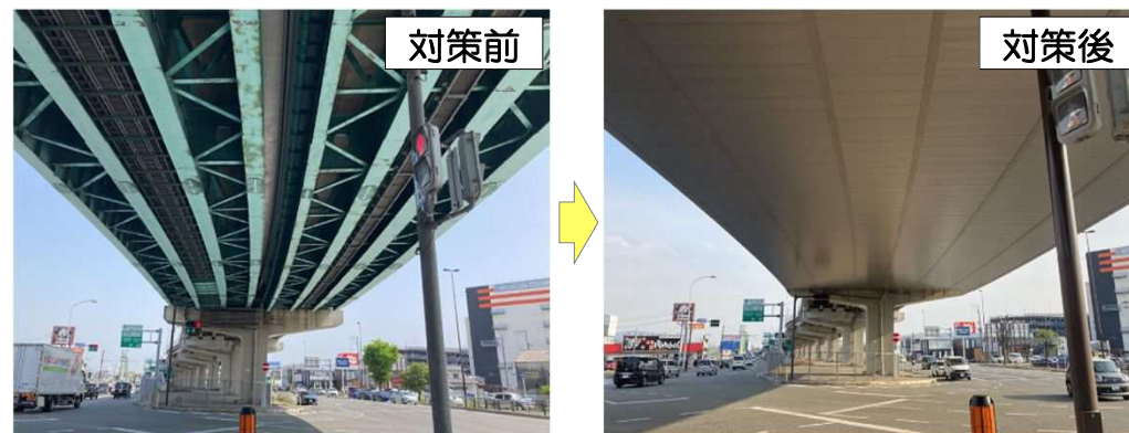
恒久足場による点検・補修の効率化
