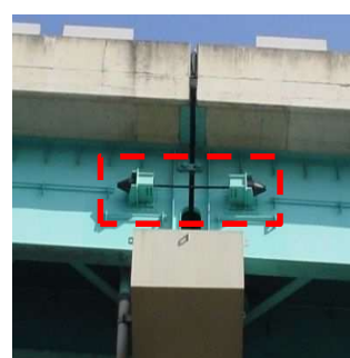
【連結ケーブル設置】
