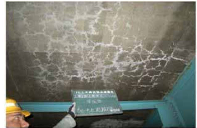
【RC床版ひび割れ】
