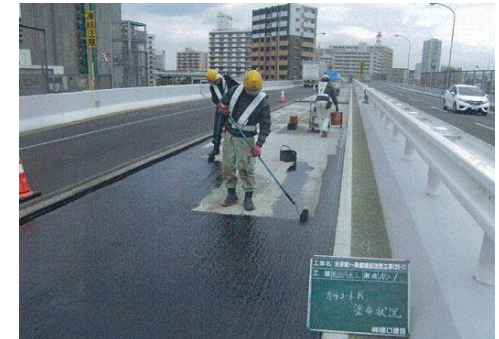
防水層の施工
