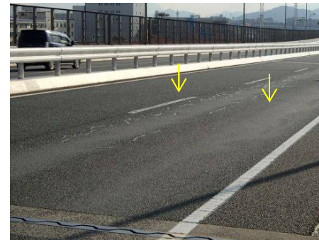
[損傷状況] ひび割れ、わだちぼれ
