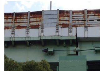
遮音壁腐食状況
