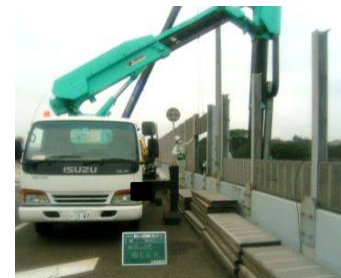
遮音壁取替状況
