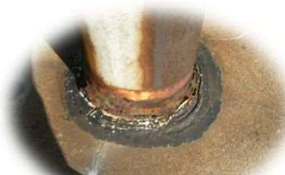
支柱基部の状態
