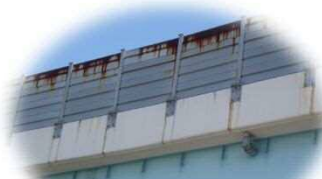
金属製パネルの状態
