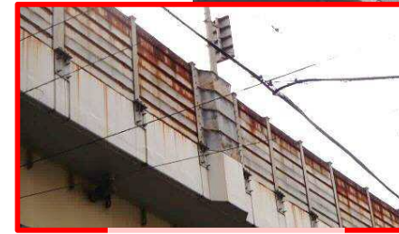
金属製パネルの状態
