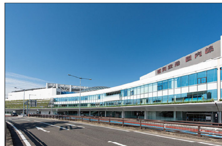
▲福岡空港国内線旅客ターミナル 提供：福岡国際空港(株)
