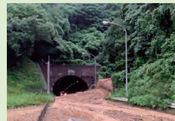
▲北九州高速4号線の被災事例(H30.7豪雨災害)
