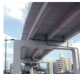
合成床版＝鋼板で覆われた構造 ⇒内部点検手法の模索
