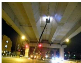
高所作業車点検
