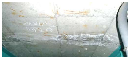
橋梁【床版下面のひび割れ】
