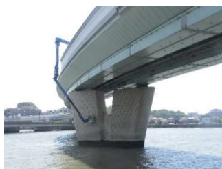
橋梁点検車点検
