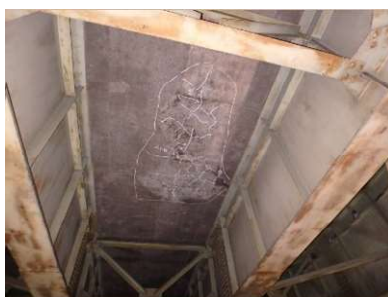
橋梁【床版下面のひび割れ】
