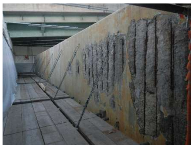
橋梁【コンクリートの剥離・鉄筋露出】
