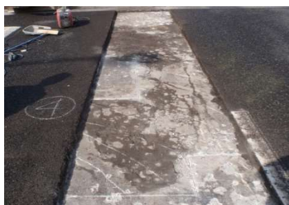
橋梁【床版上面のひび割れ】
