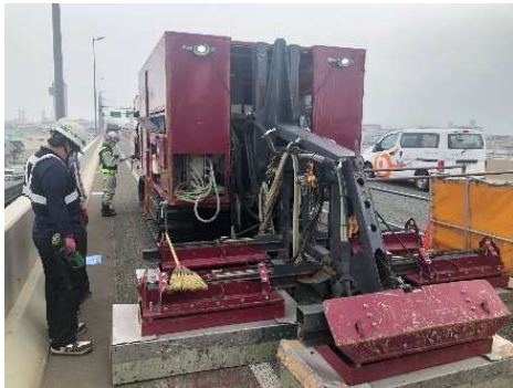
I H式舗装撤去工法
