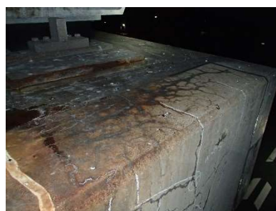
橋梁【コンクリートのひび割れ】
