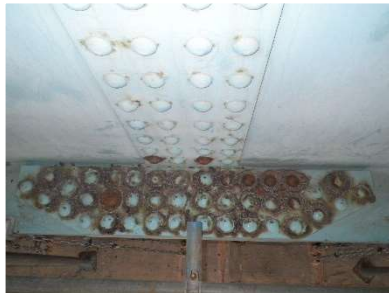
橋梁【鋼製桁の腐食】
