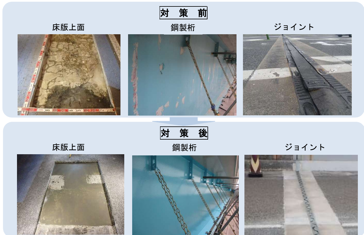
図 7 - 2 福岡高速道路老朽化・予防保全対策事業
