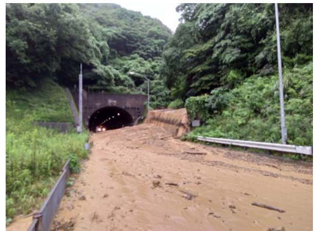
北九州高速 4 号線 春日～大里間 土砂崩れ
