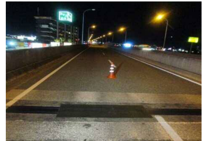
応急復旧完了
