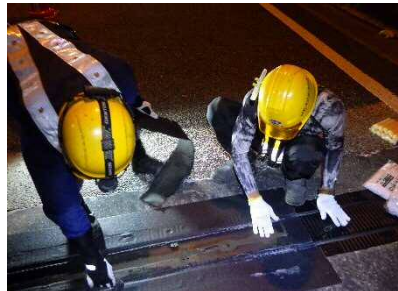
応急復旧作業
